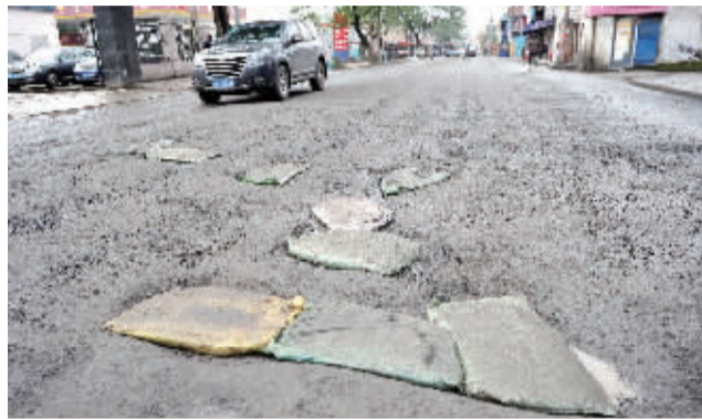
江北区倪家堰路坑洼不平，装有冷沥青用来填平道路的编织袋很多也已经损坏。
