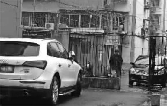
尹江岸二村内消防通道半边下面有三四十厘米高的墙。
