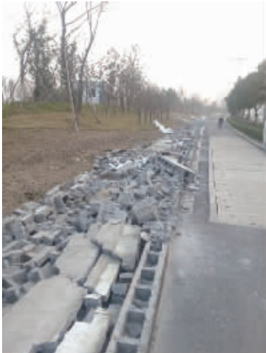
30日下午,大部分危墙已被拆除。
