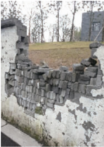
29日上午,小e在现场拍摄到的施工围墙。
