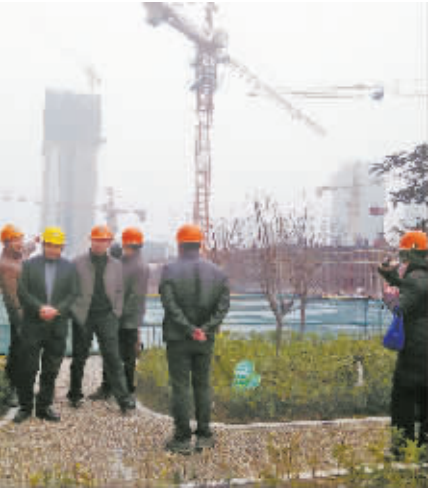
各部门进行建筑工地扬尘检查
