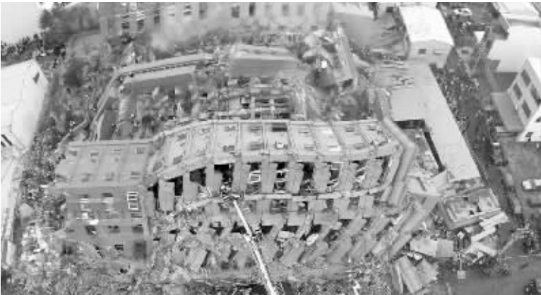
这是2月6日航拍的台南市永康区维冠金龙大楼倒塌现场。 新华社
