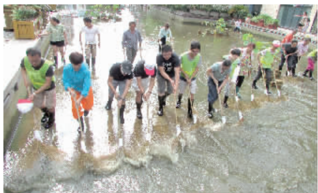
积水发黑发臭问题一直困扰着北岸琴森社区居民，江北区市政绿化养护中心党员志愿者们用扫帚把积泥、积水清理掉。
