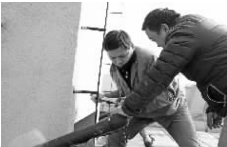
我是储世斌，供水管道抢修工，主要维修自来水管道和水表。
