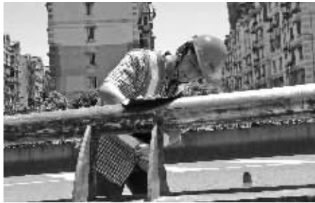
我是邓水源，主要从事市管桥梁的巡查、检测、养护、管理等工作。
