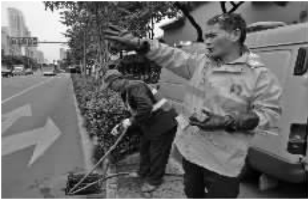
我是徐海军，排水管道养护工，主要工作是疏通养护排水管道及汛期道路排水。
