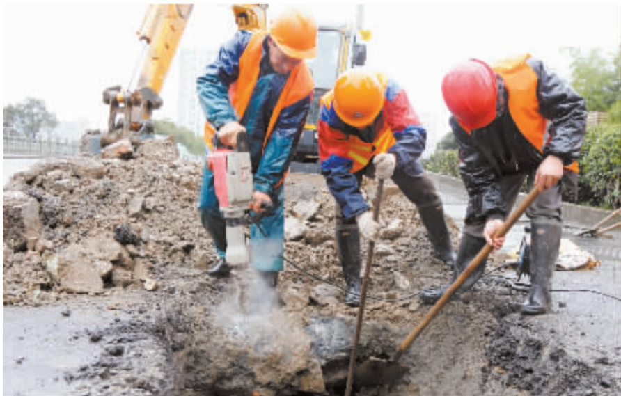
紧急抢修输水管道。
