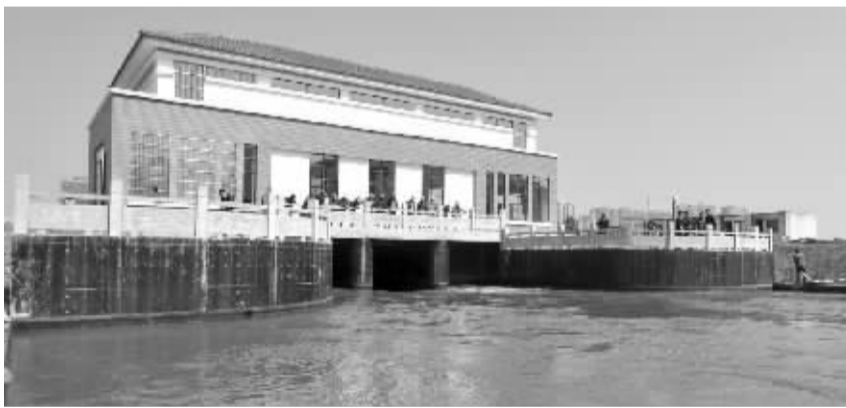
黄家河泵闸开闸。
