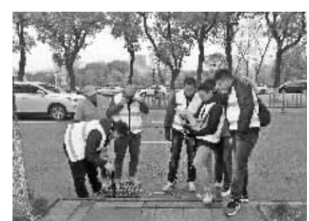
海曙区首次应用管道潜望镜探测了望京路、长春路及苍松路的13条管道，探测发现大多数管道由于大量的树根扎入，存在堵塞现象。
