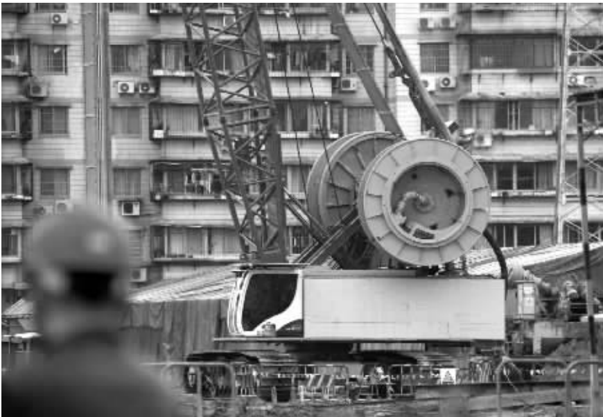
昨天,3号线儿童公园站施工现场,一台加装了两块隔音板的铣槽机在工作。记者 刘波 摄
