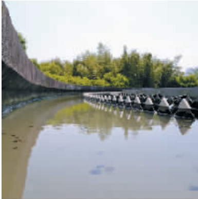
污水处理厂原本清澈的出水变得异常浑浊。
