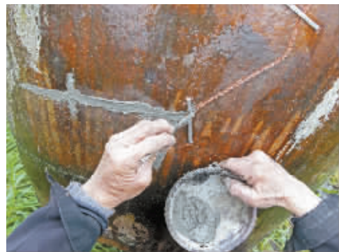
用铁砂拌和盐卤填补在凹槽内。
