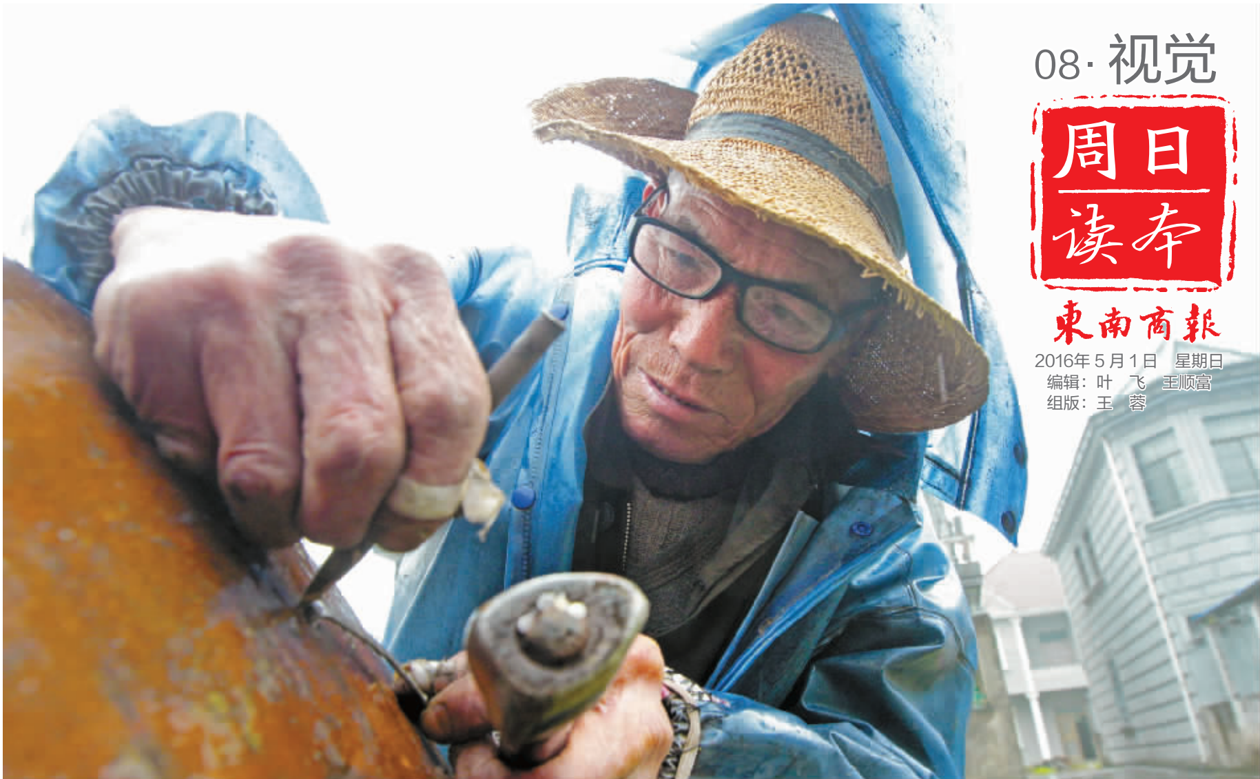
在裂缝两侧凿出小洞，然后串上铁箍。
