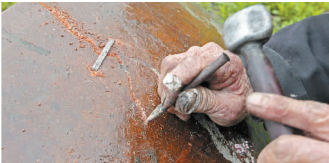
沿裂缝凿出凹槽。
