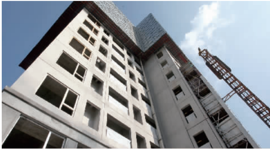
镇海万科城装配式建筑外景。(资料图片) 记者 刘波 摄
