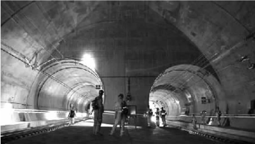
►全球最长铁路隧道内部。
