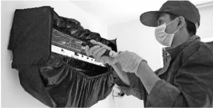
专业人员在清洗空调。记者 唐严 摄
