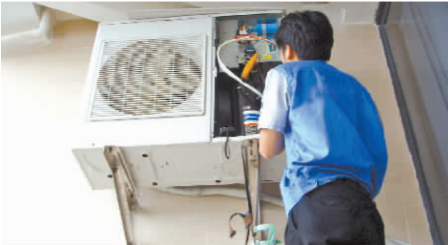
维修人员在维修空调。
