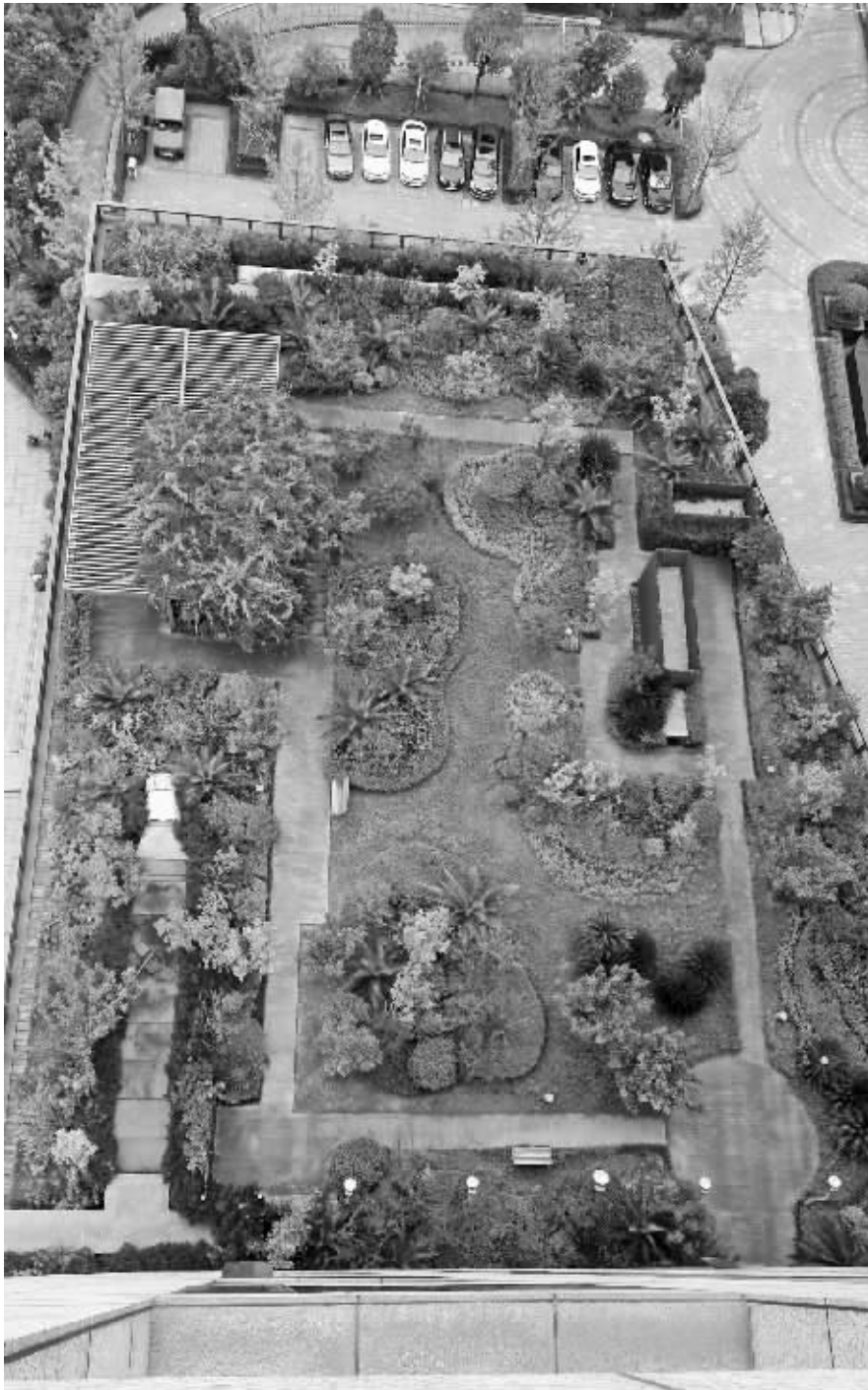
市住建委大楼裙楼上的屋顶绿化。
