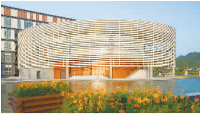
余姚市梦麟中学新校区占地约170亩，投资6.5亿元人民币，总建筑面积7.79万平方米，是余姚单体规模最大的教育投资项目。学校地处余姚市经济开发区城东新区，三面环山，依山傍水，地理环境得天独厚。 陈汉春
