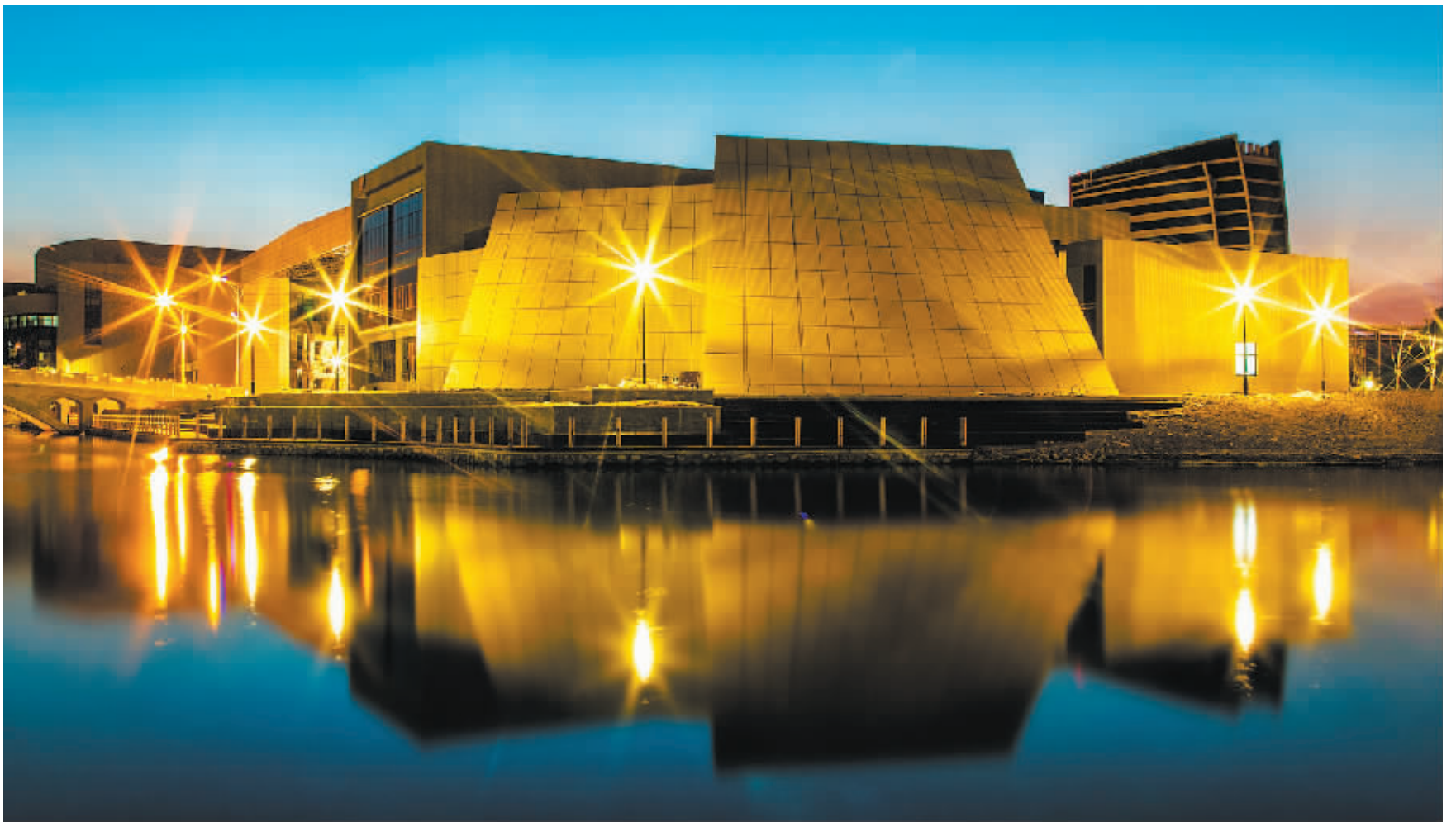
宁波工程学院风华校区二期二阶段项目是宁波市政府“三年行动计划”的重点项目，总投资额达8.6亿元，总用地面积约432亩，总建筑面积206368平方米，其中地上建筑面积194679平方米，地下车库兼人防建筑面积11689平方米。 阮少峰 摄
