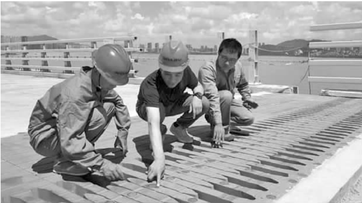
路宝集团公司员工在大桥伸缩装置现场施工。
