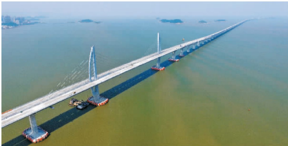
港珠澳大桥九洲航道桥的风帆造型桥塔。
