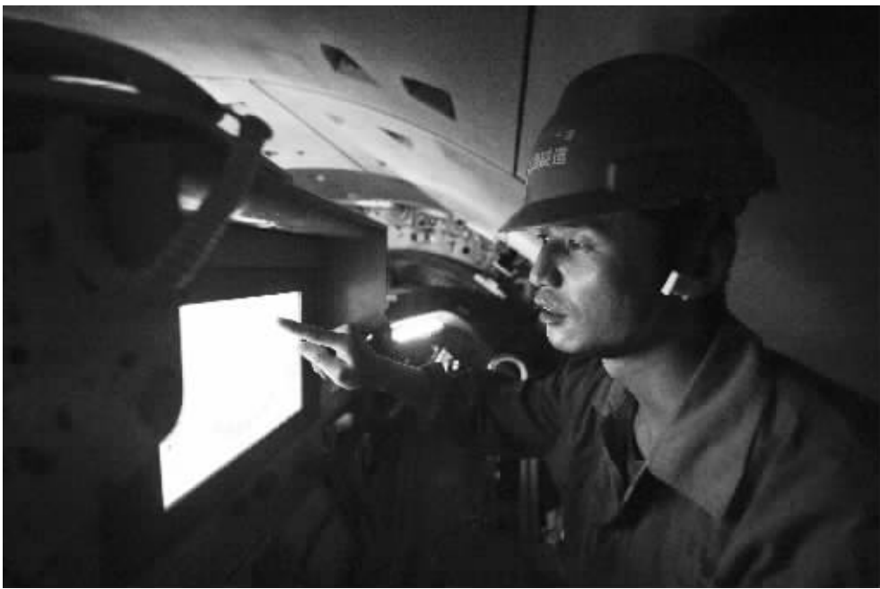
韩正恭在轨道交通3号线一期工程大通桥站地底27米的隧道内施工作业。记者 崔引 摄
