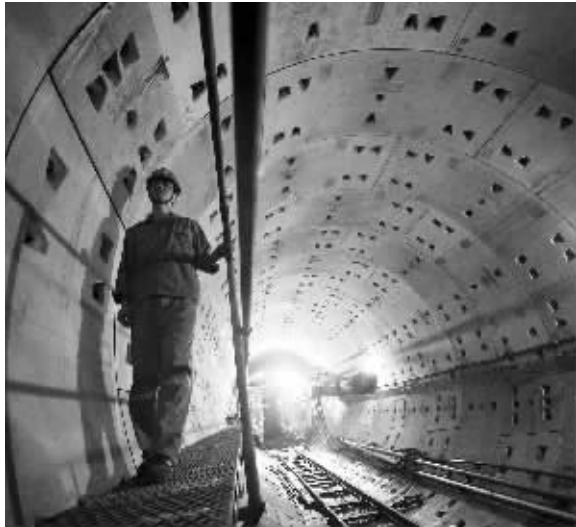
在闷热的隧道里，建筑工人每天上下班要步行2公里。
