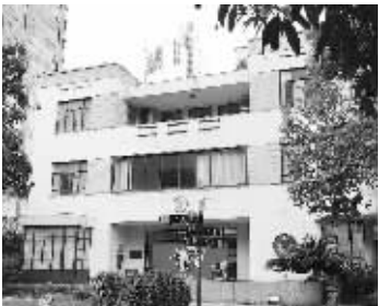
青海路44号原周湘云住宅主楼。
