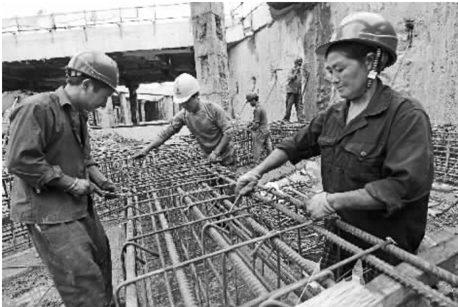
施工人员正在进行钢构施工。
