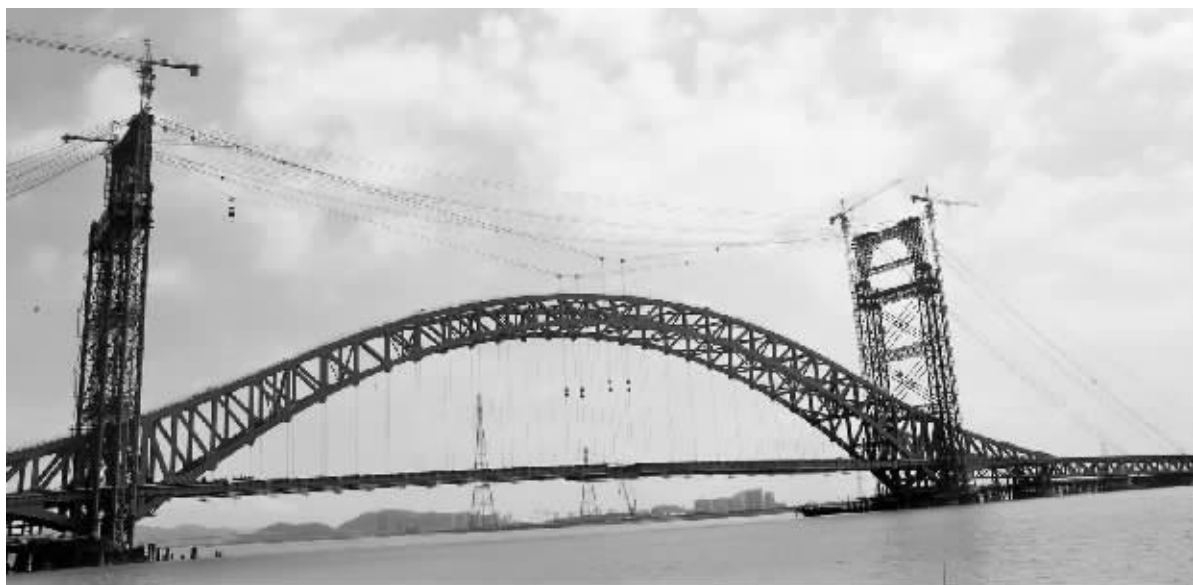
正在施工建设中的梅山春晓大桥。
