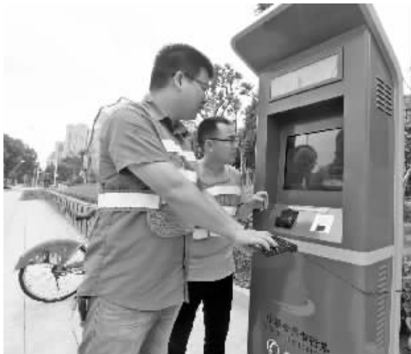
工作人员正在调试中控箱。 记者 徐文杰 摄
