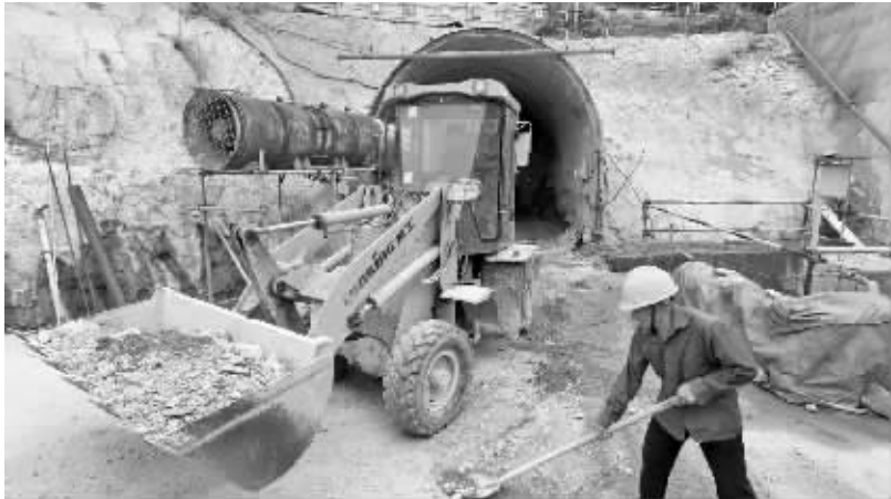
工人正在溪下隧洞出口处作业。
