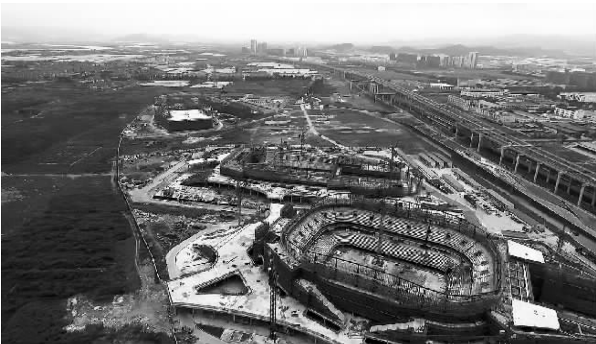
建设中的宁波奥体中心。
