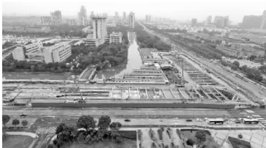
三号线一期工程鄞州区府站施工现场。
