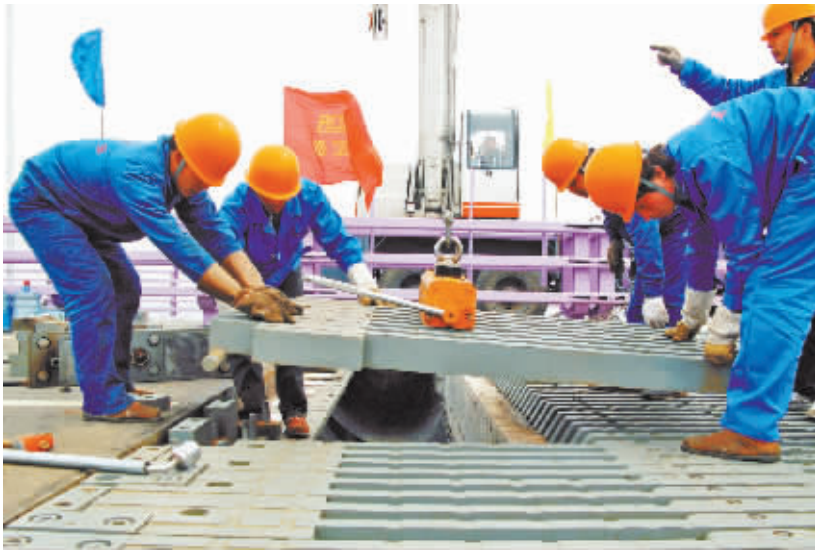
路宝集团员工在杭州湾跨海大桥工地施工。(资料图片)
