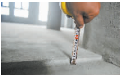
测量卫生间位置的落差,如果落差不足的话,卫生间铺的瓷砖有可能比屋内的地板高。
