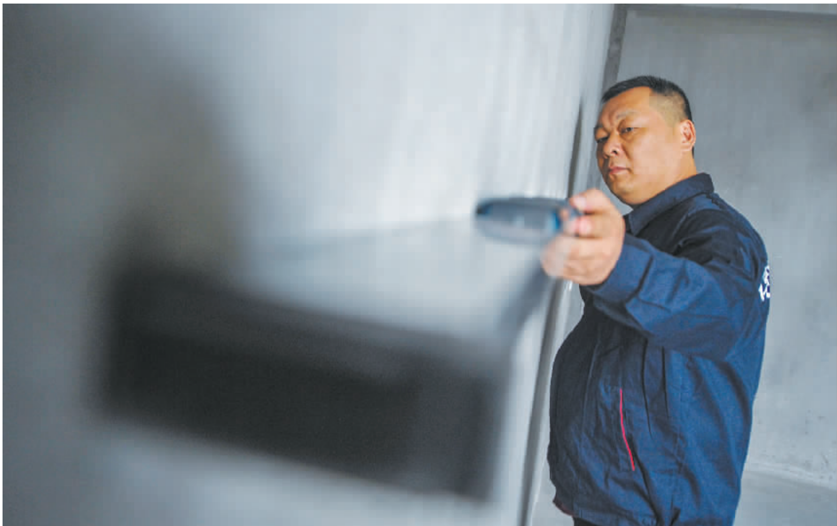
用水平仪检测房内墙壁平整度是验房的一个重要步骤。
