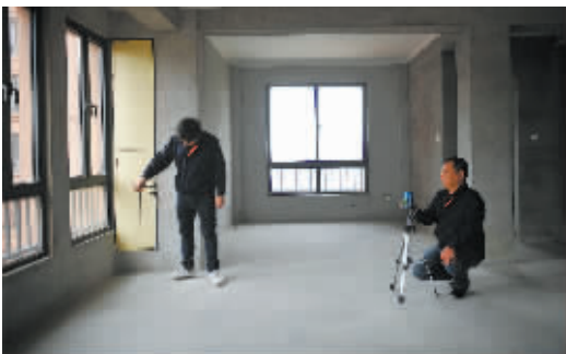
用激光水平仪检测窗面的水平度、垂直度。
