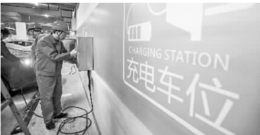
供电公司工作人员在调试充电桩设备。
