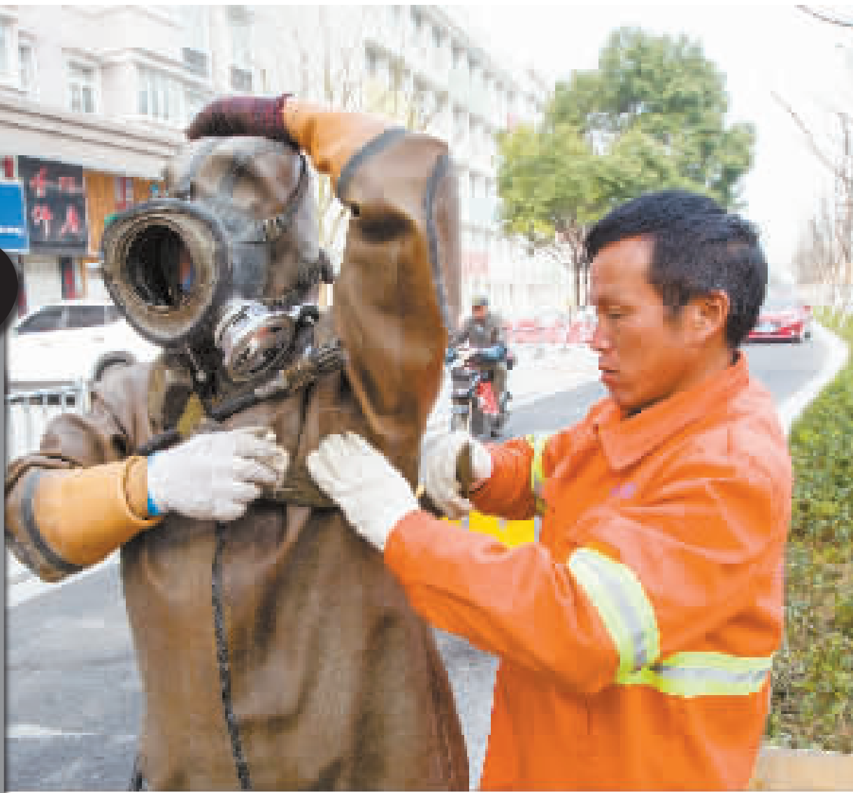
昨天,中山东路世纪东方路段的窨井边出现一名全副武装的“蛙人”。他是中山路工程施工方请来的专业检修人员。在同事的配合下,他需要从路边的窨井下潜,摸清五六米深的水下管道状况。 记者 刘波 摄
