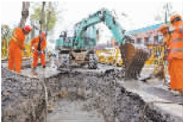
小洋江截污纳管施工现场。
