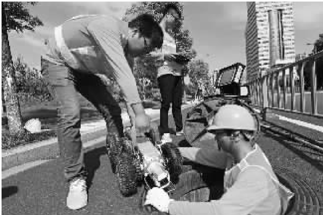
昨天上午，在江北区槐树路与桃渡路路口，市测绘设计研究院测绘队员正在使用最新引进的CCTV管道检测机器人，对地下排水管道进行检查。 记者 徐文杰 通讯员 邵月中 摄
