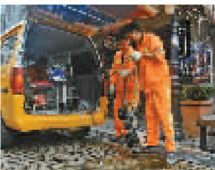
工作人员对老外滩地下管网进行检测。
