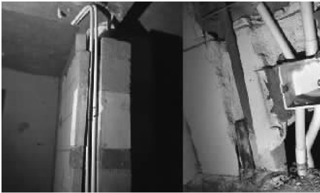
中梁首府装修现场。
