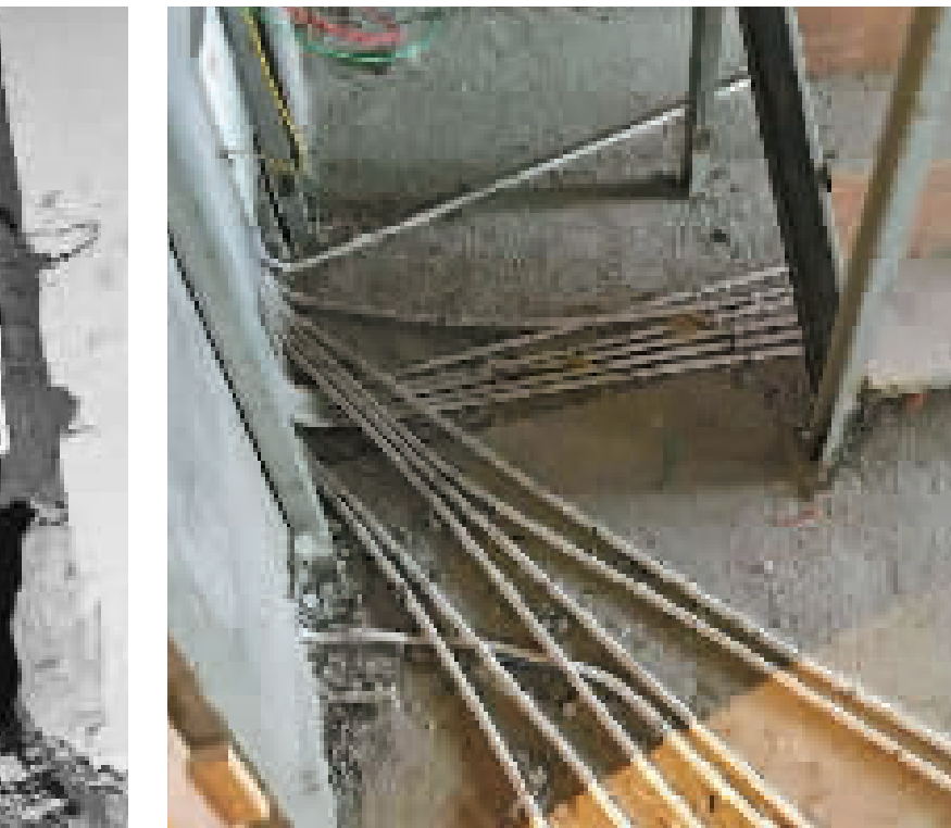
亚洲之窗装修现场。
