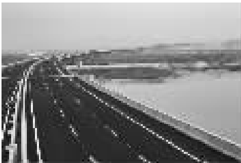
三门湾跨海大桥。 记者 刘波 摄
