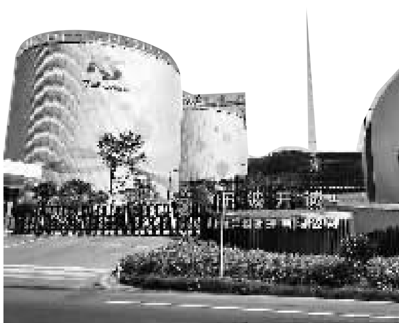
宁波开成公司位于洞桥的新厂
