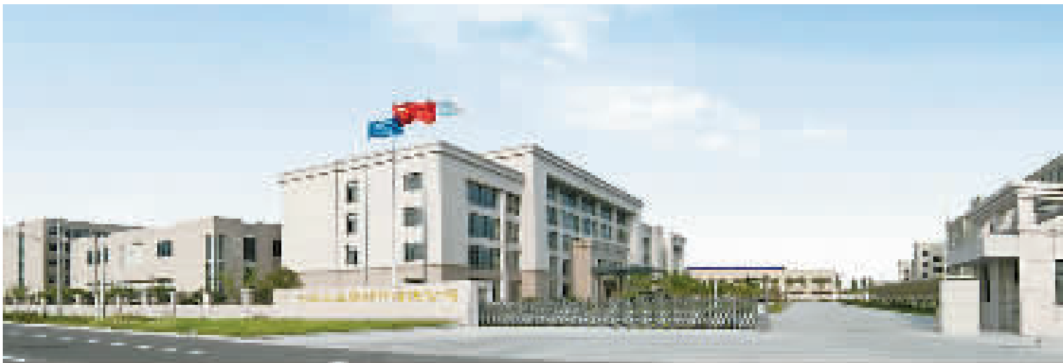
天生密封件有限公司新厂房
