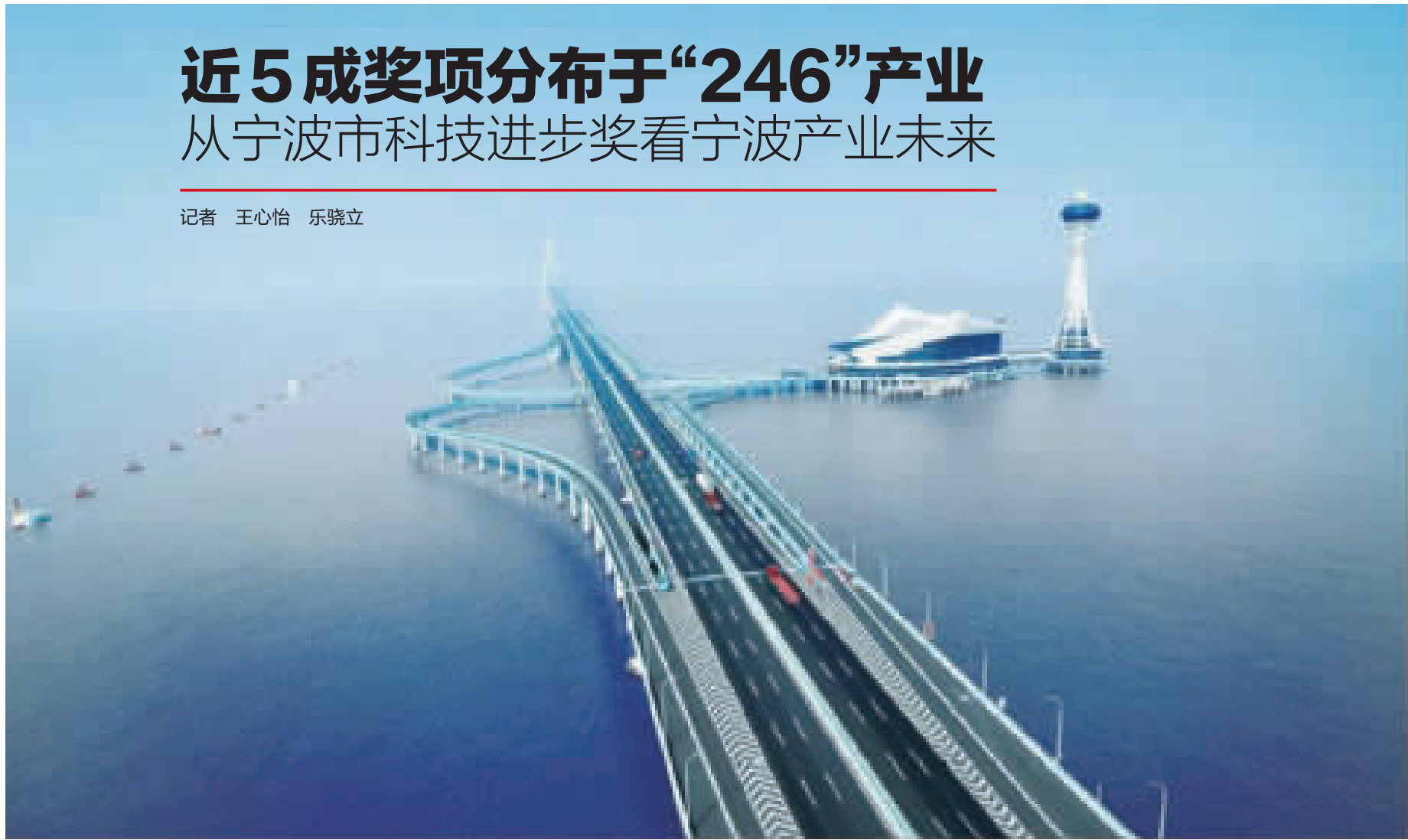
路宝研发的材料应用在杭州湾大桥上
