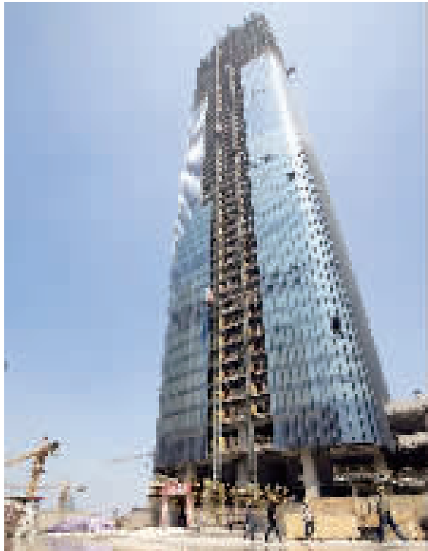
4月9日上午249米高的宁波塔主体结构封顶。
