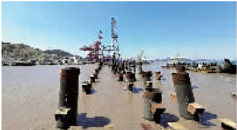
宁波舟山港穿山港区中宅矿石二期码头工程。
