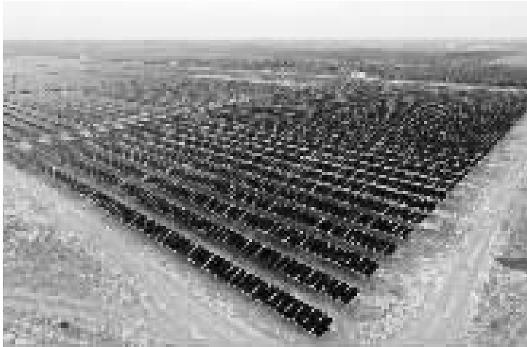
东方日升哈萨克斯坦50MW光伏电站并网。
