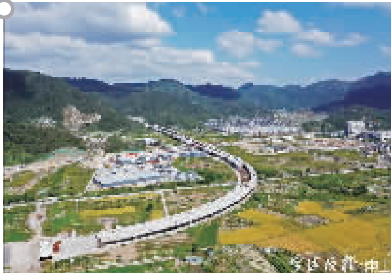
即将全线贯通的石浦高速笔尖岩特大桥。记者 杨辉 摄
