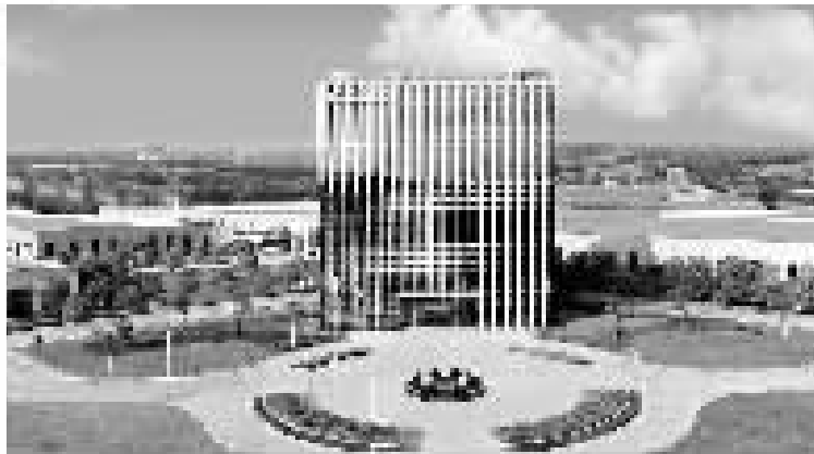
江苏博迁新材总部大楼
