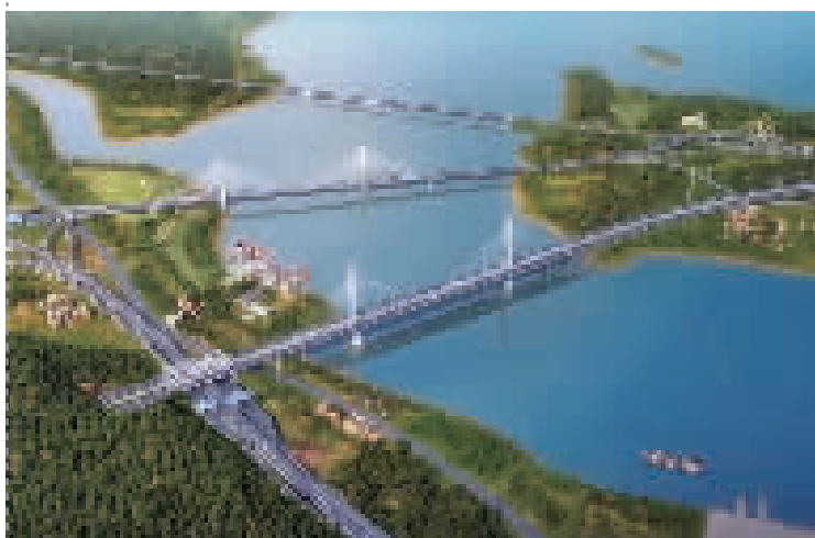
甬舟铁路富翅门大桥
