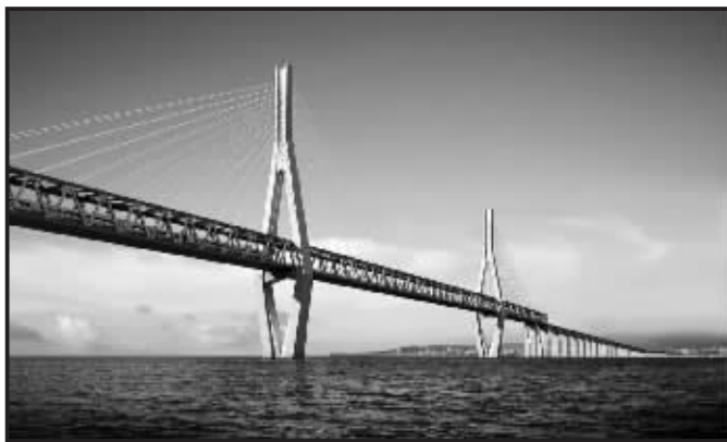
跨杭州湾铁路大桥南航道桥仰视图
