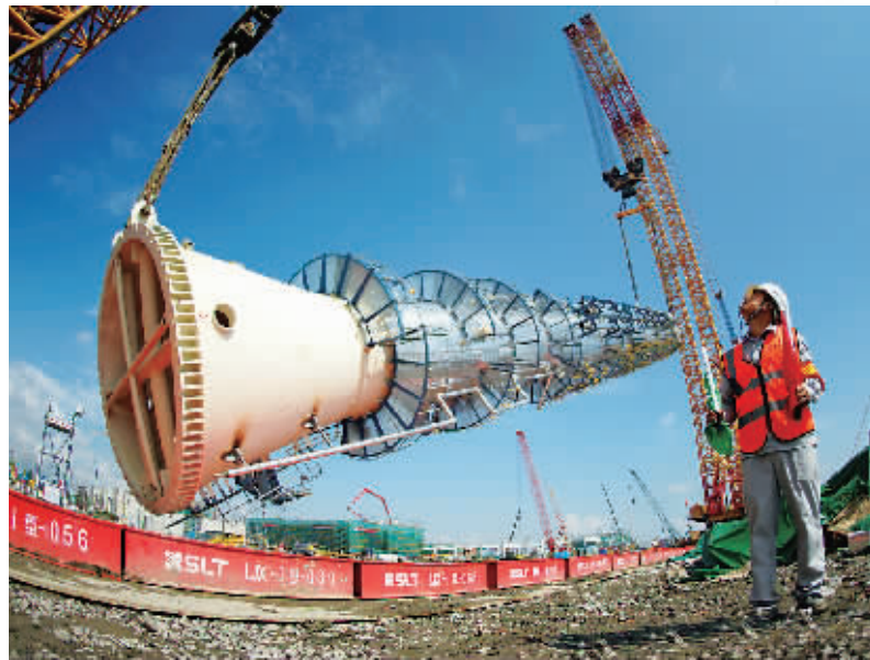
正在建设的中石化镇海基地
